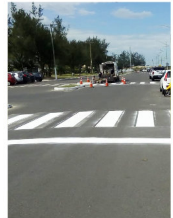
Pintura de faixas de pedestres
