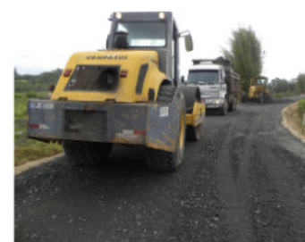
Pavimentação asfáltica da Estrada da Salinas
