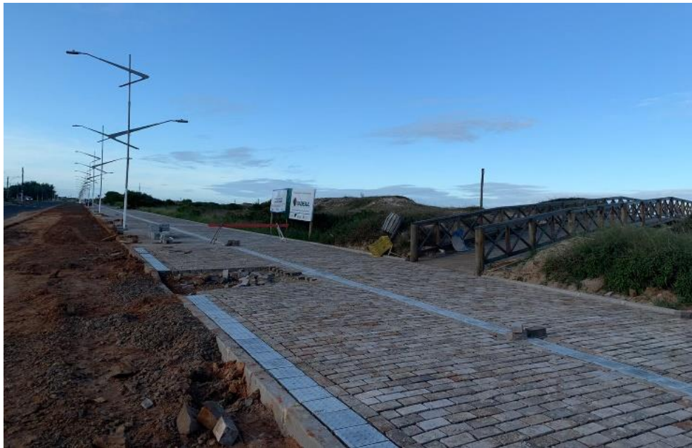
Figura 75 - Obras no Calçadão Cléo Biasi (imagem de 2022)
