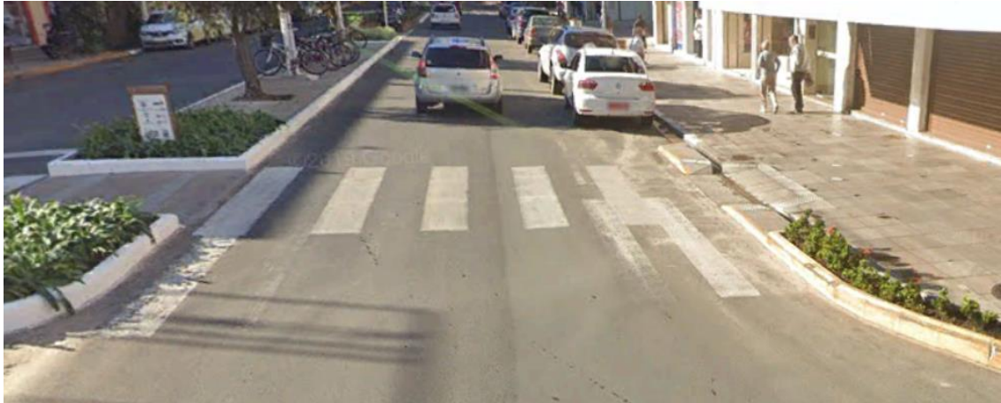
Figura 5 - Calçamento com acessibilidade
