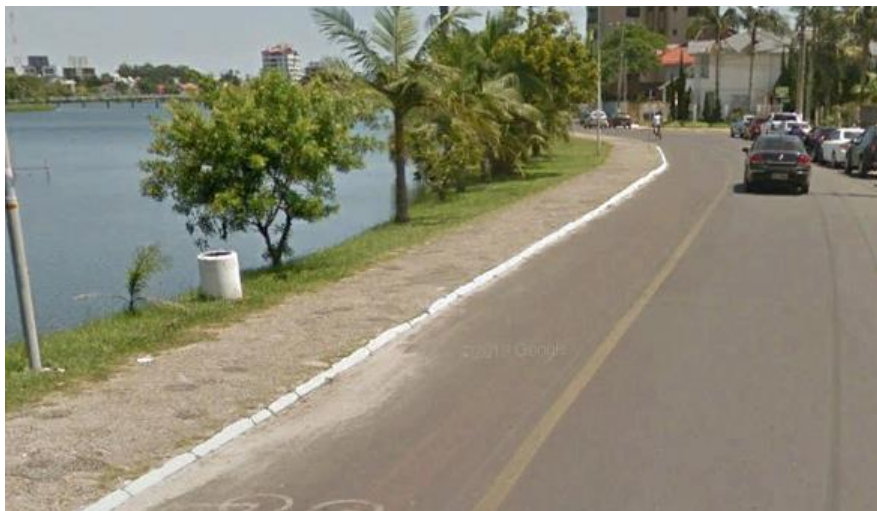
Figura 22 - Calçamento sem acessibilidade
